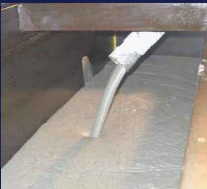
การเทมอร์ต่ำลงในแบบหล่อ
